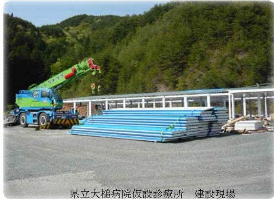
県立大槌病院仮設診療所 建設現場
